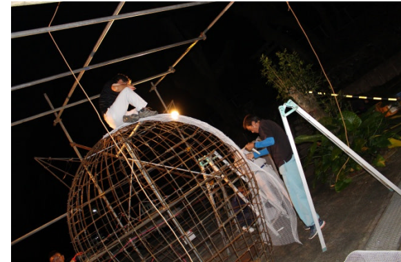
鉄筋に金網張り
